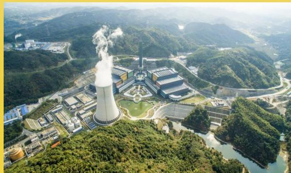
二期工程总投资 23.58 亿元，总建筑面积 8.48 万平方米。建设内容为 4 条 150 吨/天的污泥干化生产线、4 台 750 吨/天机械炉排焚烧炉和 2 套 45 兆瓦汽轮发电机组，每条焚烧生产线配置余热锅炉及烟气净化系统等。自 2021 年 9 月投运以来，二期工程各系统运行稳定、可靠，烟气排放水平优于国内同类项目，厂用电率仅为 9.2%，能效水平位居国内前列。二期建成后，日处理湿污泥 500 吨、生活垃圾 2800 吨，全年可供 110 万居民用电，年节约标准煤 18 万吨，年减排二氧化碳超过 44 万吨，创造了“综合协同、以废治废” 城市固废处置的“长沙模式”，并获评城市固废处理湖南省科普基地。
