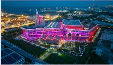
上海宝山再生能源利用中心项目是我国首个超大型公园式垃圾焚烧发电厂重大工程，项目占地面积约13.5万m<sup>2</sup>，总建筑面积为16.1万m<sup>2</sup>，日处理厨余垃圾500吨、餐厨垃圾300吨，总焚烧规模为3000t/d，每年可发电8亿度，相当于全市2400万常住人口四个月的用电量。项目围绕“宝山有山”的设计理念，
