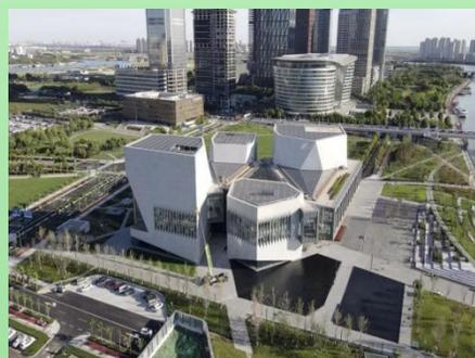
学院设有音乐厅、演奏厅、排演厅及黑盒剧场四个单体建筑，均为不规则多面体外形；为了满足整体建筑悬浮的设计理念，地上主体钢结构大量采用悬挑形式，节点复杂，结构强度高、钢板厚度大，连廊最大跨度73m，重达一千两百吨，场地狭窄，施工组织难度大；单体间经公共大厅及折线形五条大跨度连廊联结而成，连廊上下两层，用于办公及教学；底层通透的“茱莉亚幻想”公共大厅为开放式共享空间，与海河景观完美的融为一体。
