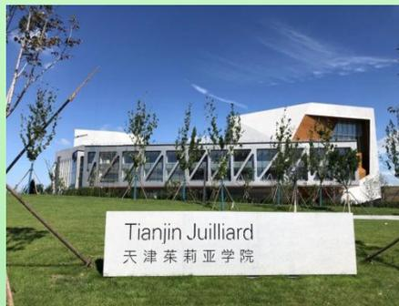
天津茱莉亚学院位于天津滨海新区于家堡金融区，西临海河、东邻高铁于家堡站。项目总建筑面积45000平方米。地下两层，钢筋混凝土结构；地上最高六层，主体为钢结构。工程由天津中冶名金置业有限公司投资建设，美国迪乐公司和中国华东建筑设计研究院设计，中冶天工集团有限公司总承包。建设内容包括：桩基工程、基础工程、钢结构工程、装饰装修、幕墙工程、舞台灯光机械、电气设备安装、给排水及通风空调、室外管网、景观绿化等。
